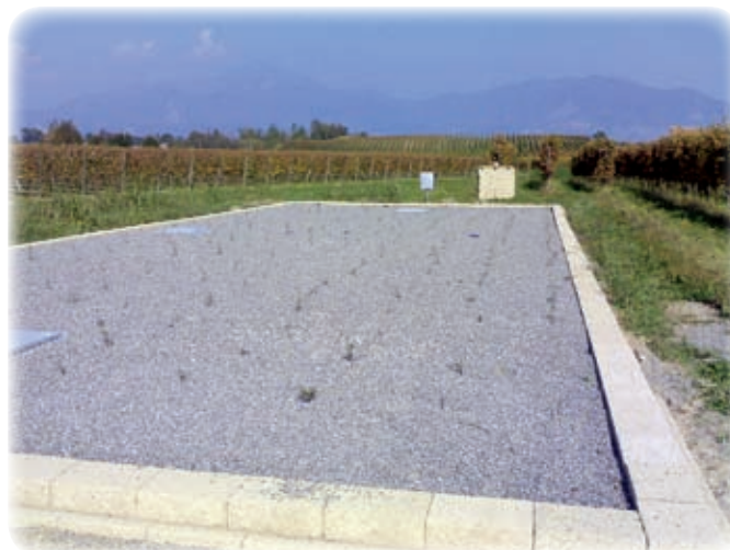
Figura 5 - Realizzazione del bacino di fitodepurazione a flusso verticale FDV con messa a dimora di piante da fitocella.
