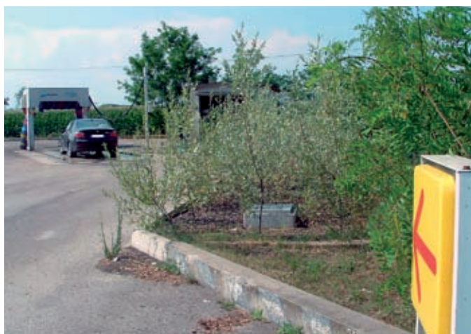
Figura 4 - Impianto di fitodepurazione Geofilter® PP al servizio di un autolavaggio.
