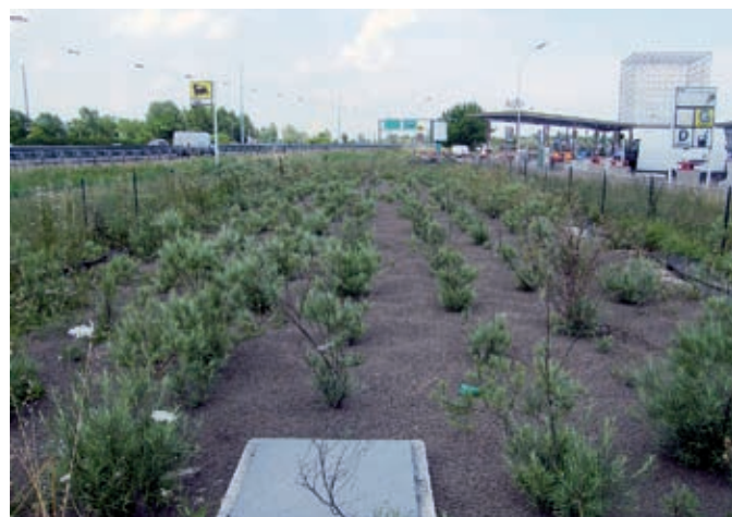
Figura 5 - Impianto di fitodepurazione Geofilter® PP al servizio di una stazione carburanti presso Area di servizio autostradale.
