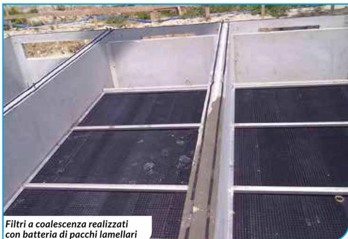
Filtri a coalescenza realizzati con batteria di pacchi lamellari
